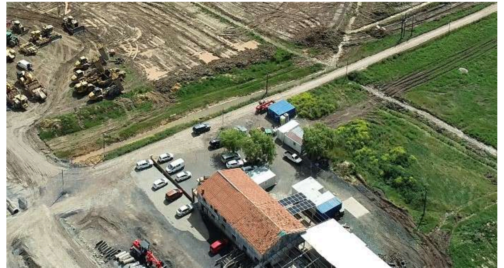
OBRA PSIR LA PASIEGA INSTALACIÓN FOTOVOLTAICA PARA ABASTECER OFICINA, INSTALACIONES PERSONAL Y TALLER DE MAQUINARIA
